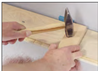
Endefugerne samles med en hammer og en slagklods. De langsgående fuger og endefugerne går derved i hak automatisk. Fortsæt lægningen i hele rummet.
